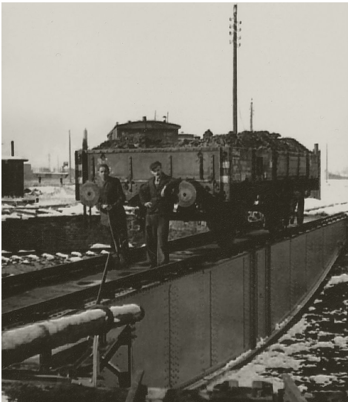
Druga Powiększona Obrotnica W Skarżysku Również O Napędzie Ręcznym. Zdjęcie Wykonano W 1928 Roku. Obrotnica Ta Miał Długość Prawdopodobnie Od 24 Do 25 Metrów. Konstrukcja Obrotnicy Była Nitowana. Tak Duża Obrotnica Powodowała Że W Skarżysku Mogły Stacjonować Najdłuższe I Najcięższe Parowozy PKP. (Zdjęcia Fotopolska.eu)
