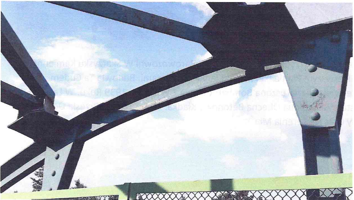
Nitowane Elementy Kładki
