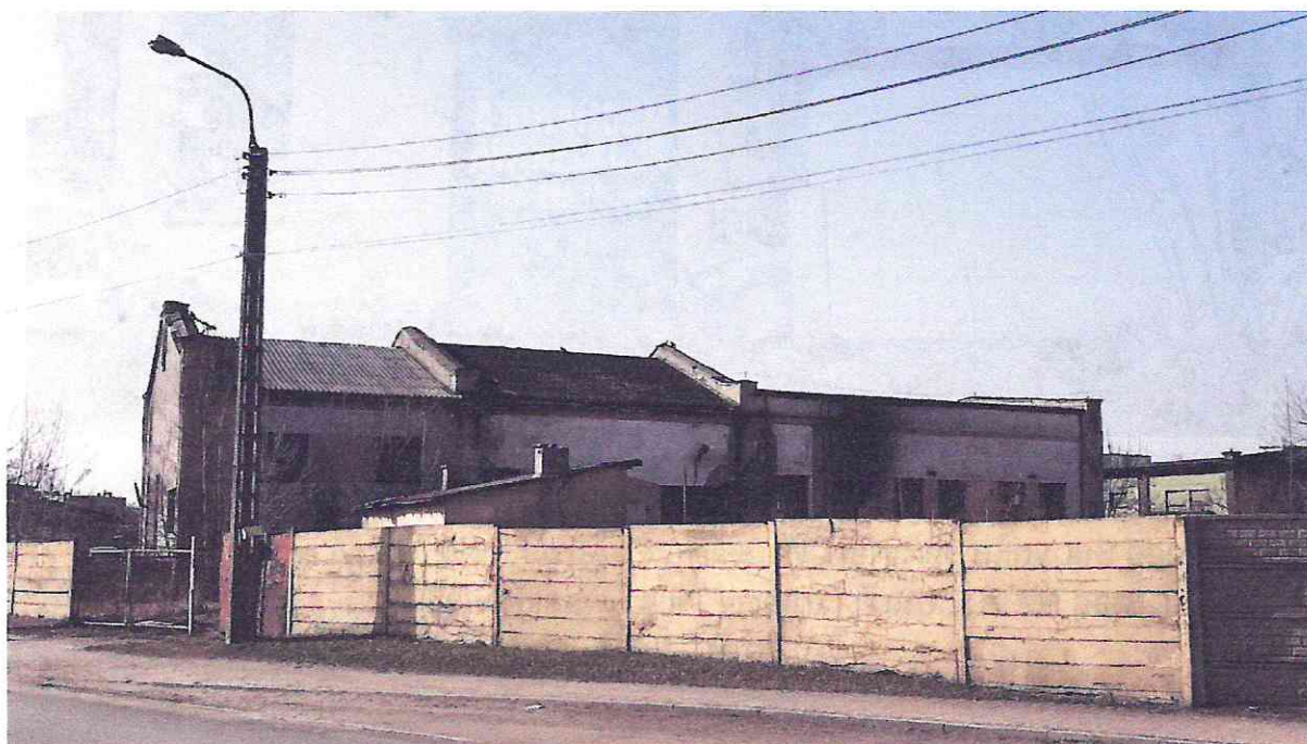
Potężna Kotłownia Parowozowni Wybudowana Po Pierwszej Wojnie Światowej. Stan Na Rok 2021 (Zdjęcie Piotr Mańkowski)
