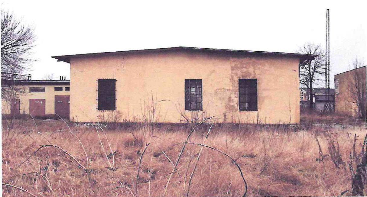
Mały Magazyn. Budynek Z Począku Xx Wieku
