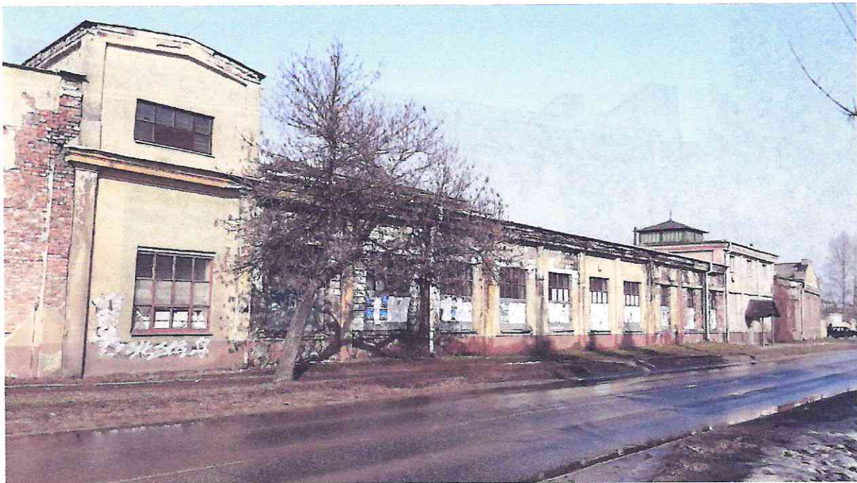
Warsztaty Zewnętrzne W Dali Przylegający Budynek Tokarni.
