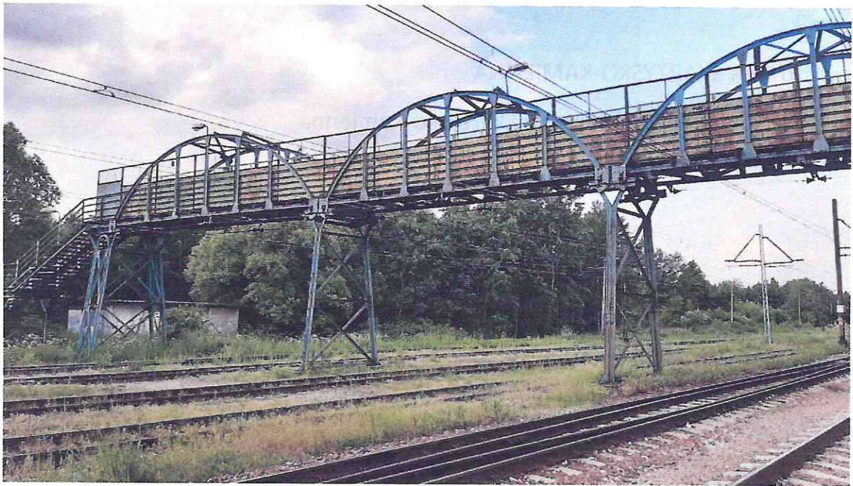
Kładka Znajduje Się Na Ulicy Pięknej. Przerzucona Jest Nad Torami Linii Kolejowej 25.
