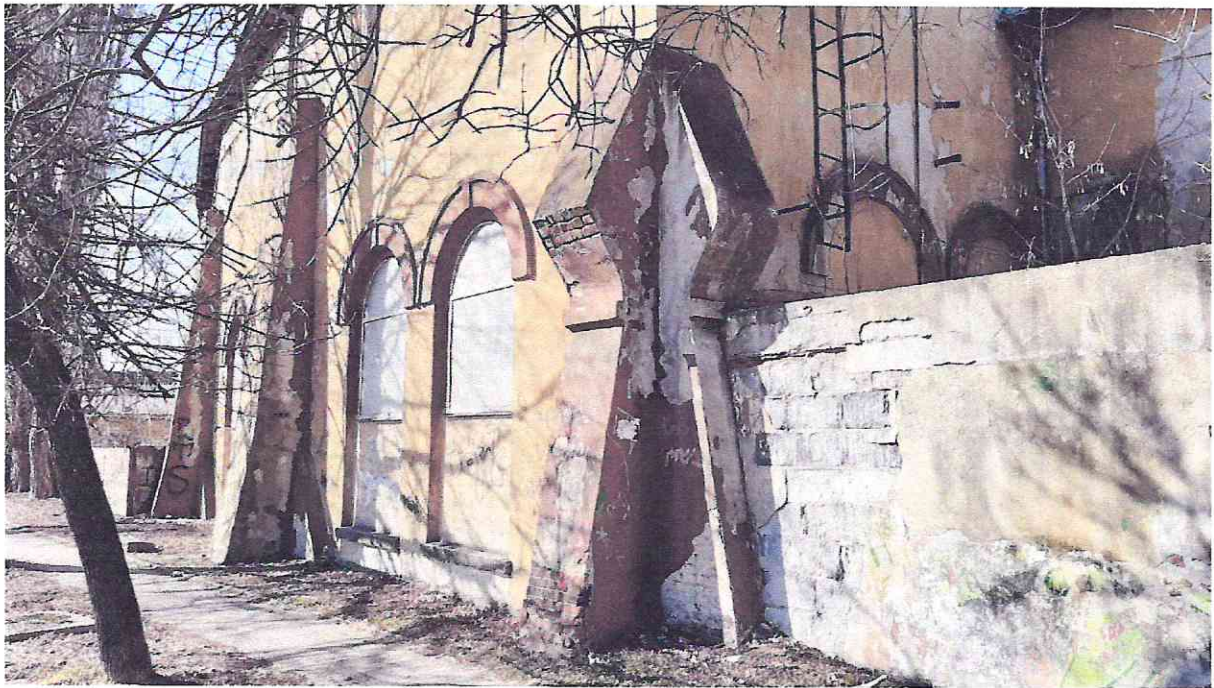
Elementy Dekoracyjne Wysokiego Wachlarza. Na Drugim Planie Potężne Przypory Rzecz Nie Spotykana W Budownictwie Tego Typu Obiektów Na Zachodzie Europy.
