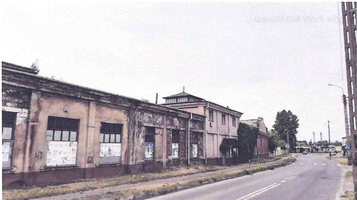
Budynki (Warsztaty Zewnętrzne) Parowozowni Połączone W Jedną Architektoniczną Całość. W Środkowym Budynku Mieści Się Od 20 Lat Klub
