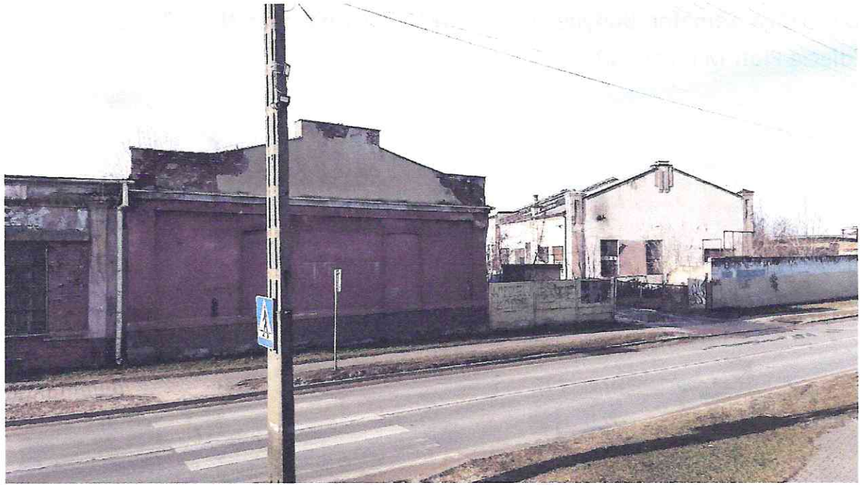
Budynki Tokarni I Kotłowni Należące Do Zespołu Budynków Parowozowni W Skarżysku. Stan Na 2021 Rok (Zdjęcie Piotr Mańkowski)
