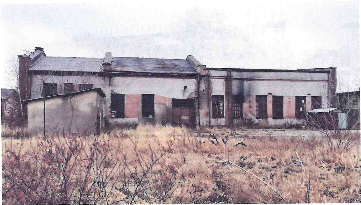
Kotłownia Od Strony Ulicy Towarowej Naprzeciw Przystanku Mks.
