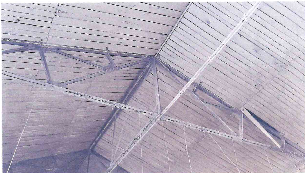
Dach Tokarni Stalowa Kratownicowa Nitowana Konstrukcja Z Xix Wieku.
