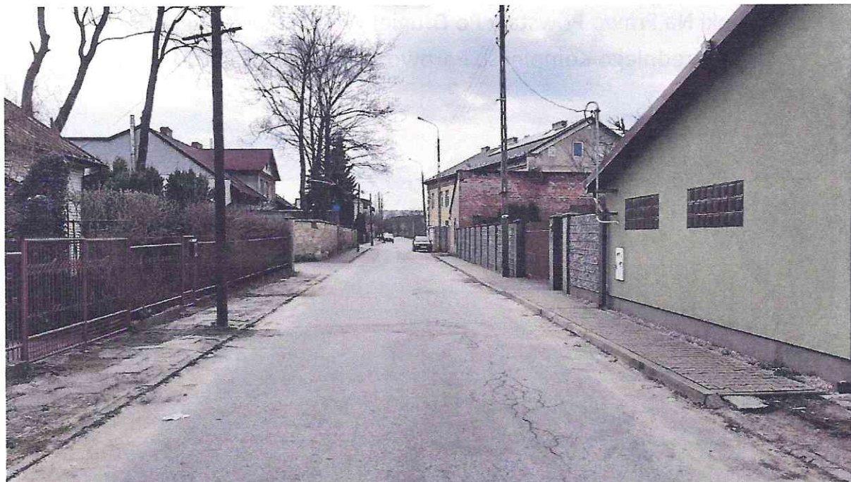
Widok Parowozowni Z Ulicy Fabrycznej Wybiegającej Z Ulicy 3 Maja. Ulica Fabryczna Wraz Ulicą 3 Maja Stanowi Południową Część Osi Architektonicznej Wybiegającą Od Parowozowni. Stan Na 2021 Rok (Zdjęcie Piotr Mańkowski)
